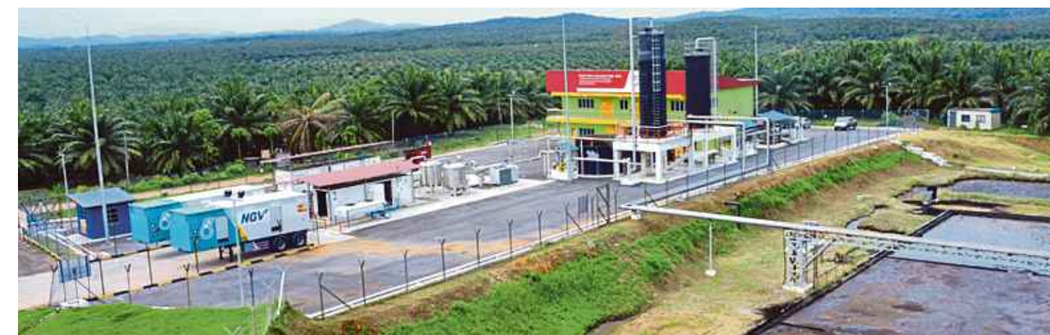
Loji komersial Bio-CNG pertama di dunia menggunakan biogas sawit dibangunkan oleh MPOB, FPISB dan SDOE di Kilang Kelapa Sawit Felda Sg. Tenggi, Selangor
